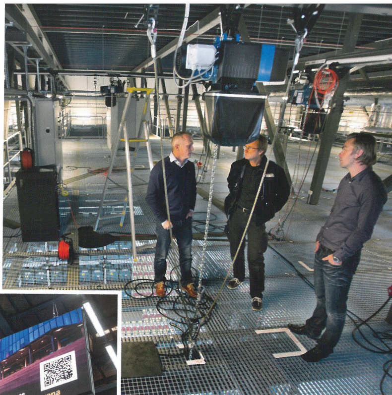
Åtta DC-Com 10 telfrar lyfter LED-skärmarna.
