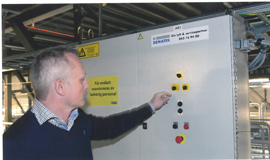
Telfrarna i arenan kan även manövreras från styrkåpet.
